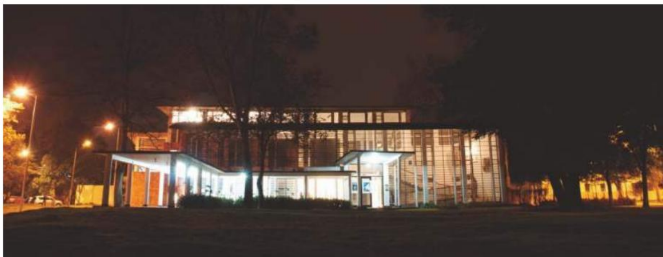
▲ Antiguo edificio de la imprenta, hoy Museo de arquitectura, diseñado por Leopoldo Rother
