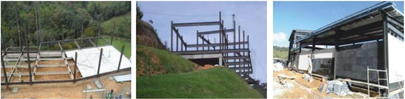
▲ Proceso constructivo Casa de Metal y Vidrio.
