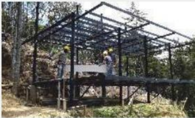
▲ Proceso de montaje de la estructura.
