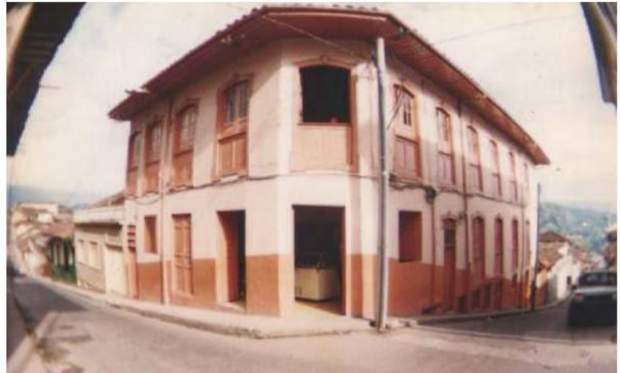
▲ Casa típica de bahareque, actualmente demolida, obsérvese los elementos constitutivos, relación vanos – llenos, aleros y zócalos, ventanas, postigos y otros componentes propios de la arquitectura de la Colonización Antioqueña.
