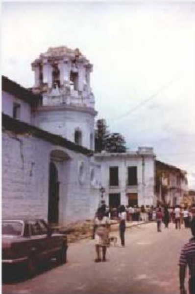
Terremoto de Popayán. Daños en inmuebles patrimoniales construidos con tierra, 1983.
